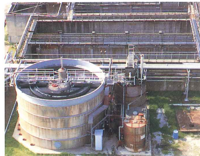
▲日量2400トンの廃水をTROLLで処理した場合、既設の好気性処理設備に比べ、ランニングコストは10分の1を達成。
