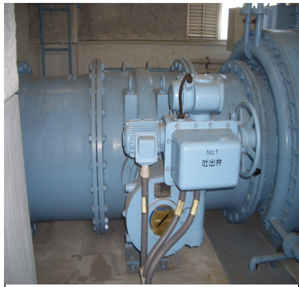
5 No.1ポンプ用電動吐出弁工場分解整備
