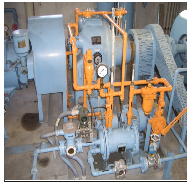
3 No.1ポンプ用減速機工場分解整備
