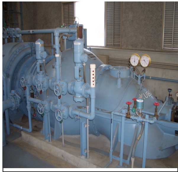
1 No.1横軸斜流ポンプ工場分解整備
